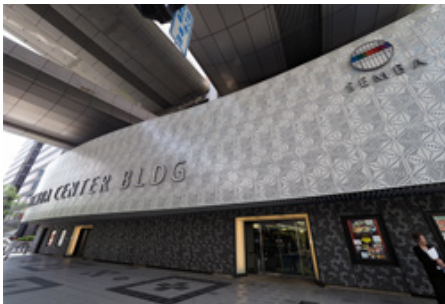
屋上を阪神高速13号東大阪線および中央大通の高架道路が通っている船場センタービル
